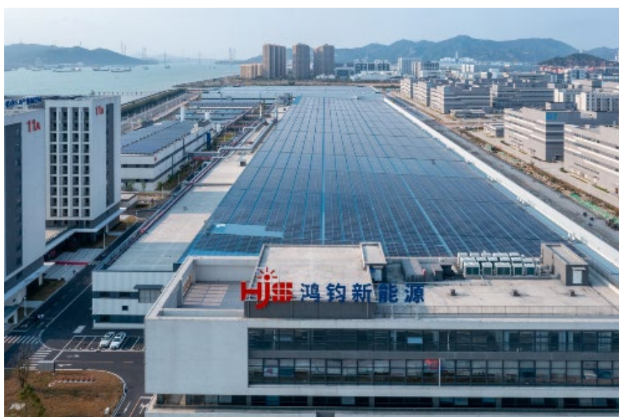
图 5 - 3 鸿钧新能源 17.6MW 光伏项目交付使用
