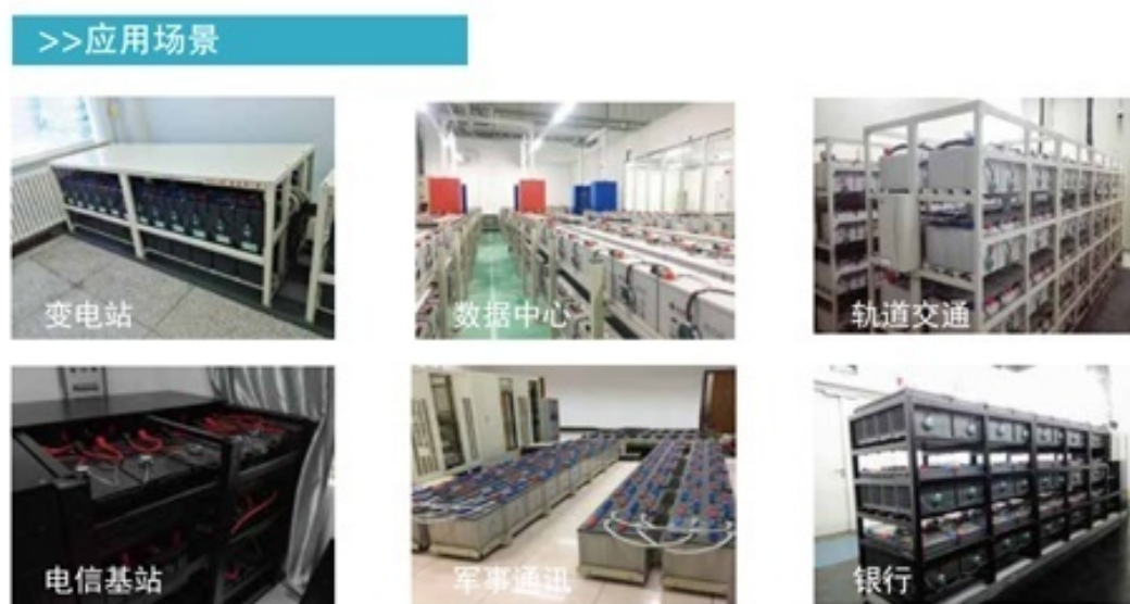
图 4 - 17 派诺科技的 PBAT 蓄电池云监测解决方案有较多应用场景
