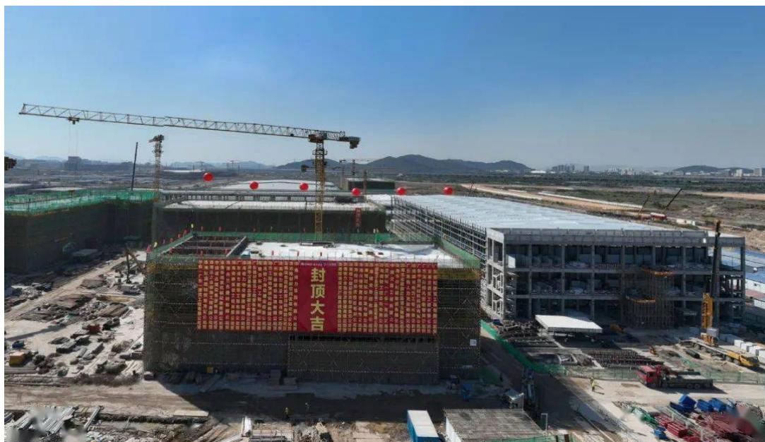
图 5 - 2 埃克森珠海项目一期厂房封顶
