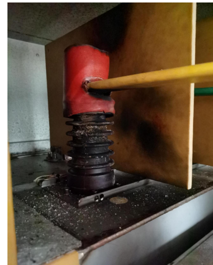
支柱绝缘子放电
