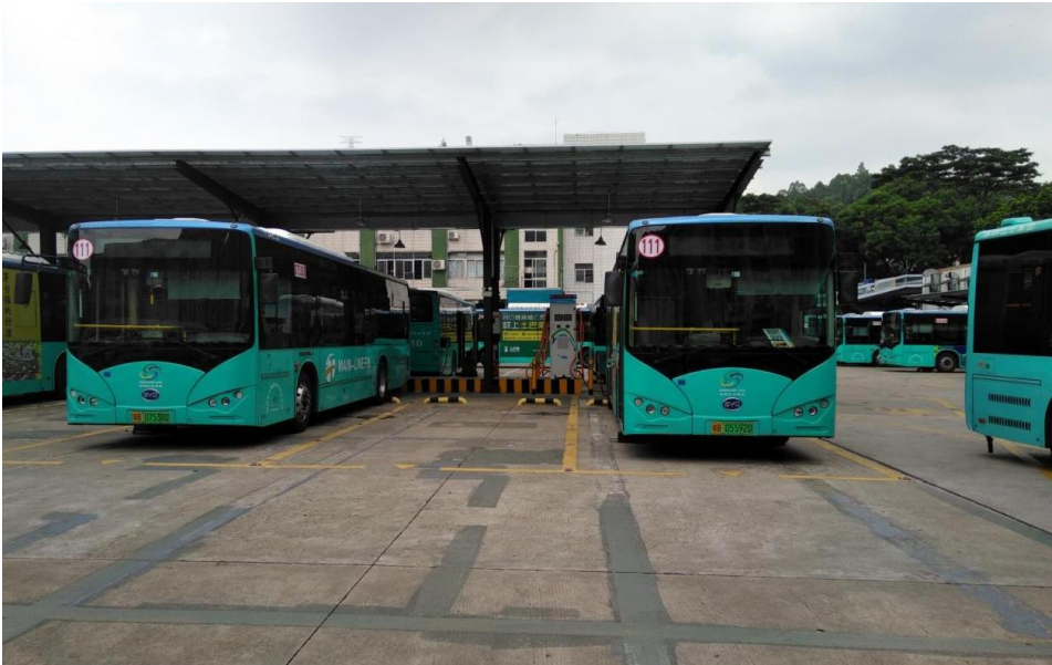
深圳电动公交车充电站
