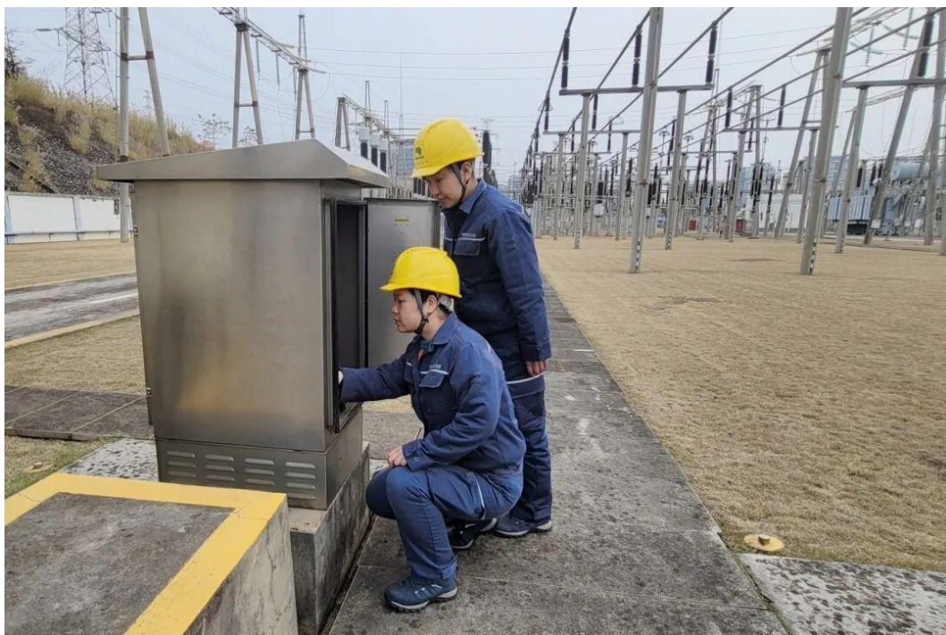
▲2月13日，南方电网广西柳州供电局工作人员积极开展变电站防潮巡视工作，重点检查变电站内密封条、防潮柜等设备的防潮设施是否完好，对变电站内的温湿度进行实时监测，确保设备不受潮气侵袭。
