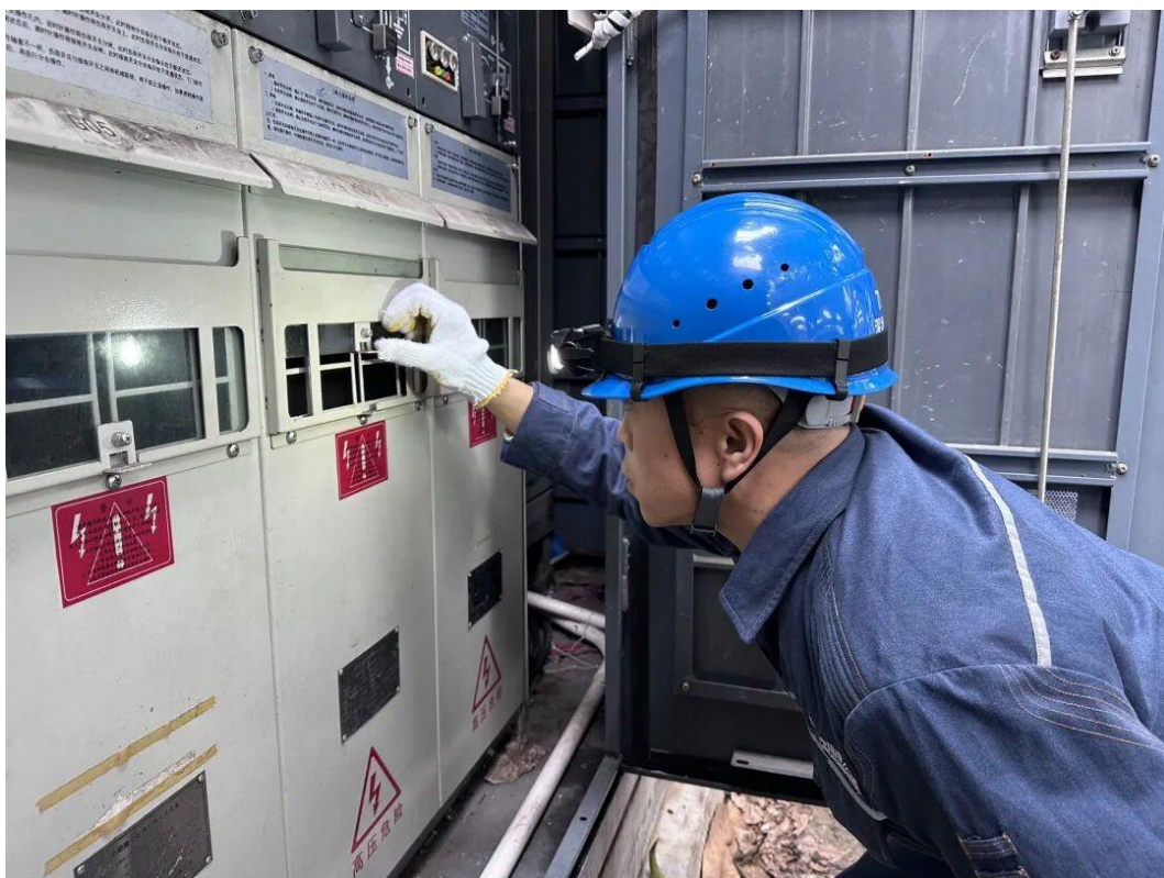
▲2月14日,南方电网深圳福田供电局工作人员开展户外设备防潮专项巡检,重点检查设备是否受潮。(陈家超 高加佑 摄)
