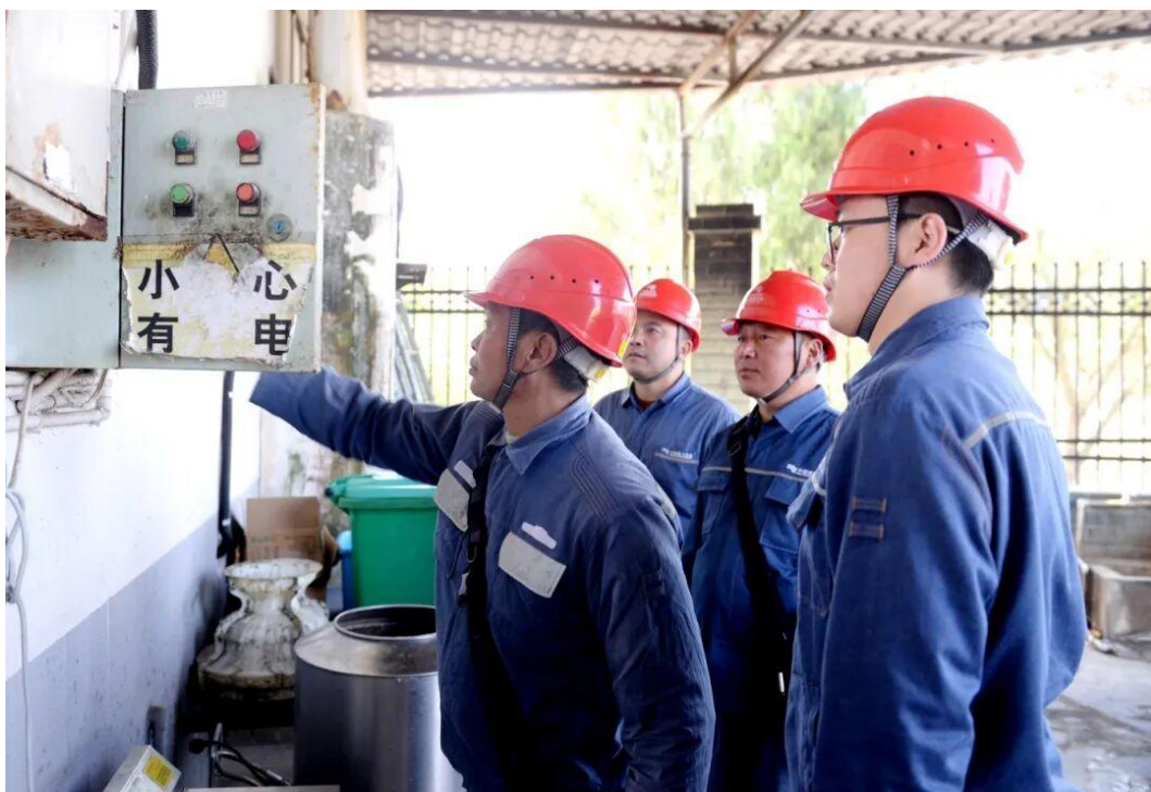
▲南方电网贵州遵义凤冈供电局党员服务队走进遵义市凤冈县进化镇街道，为居民检查用电设备。（龚红摄）
