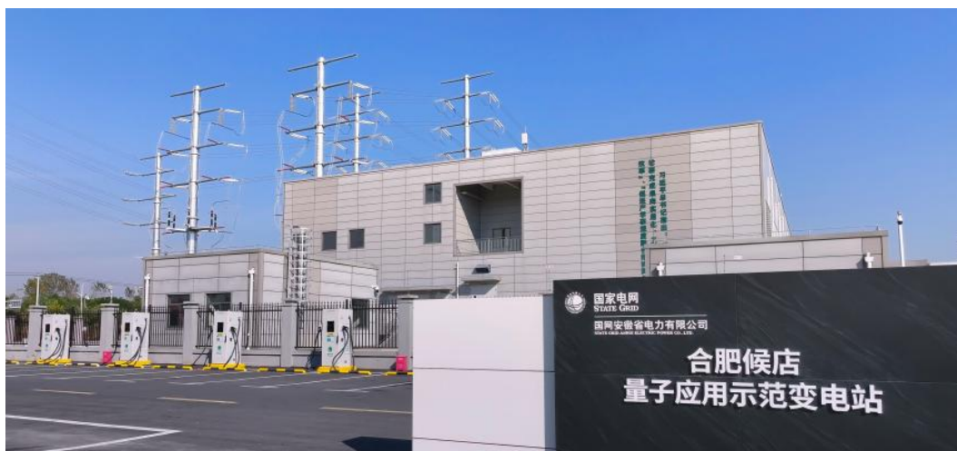
▲合肥候店量子应用示范变电站
