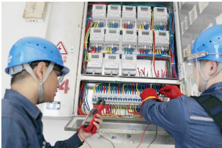
▲外伶仃岛电表更换工作已完成
