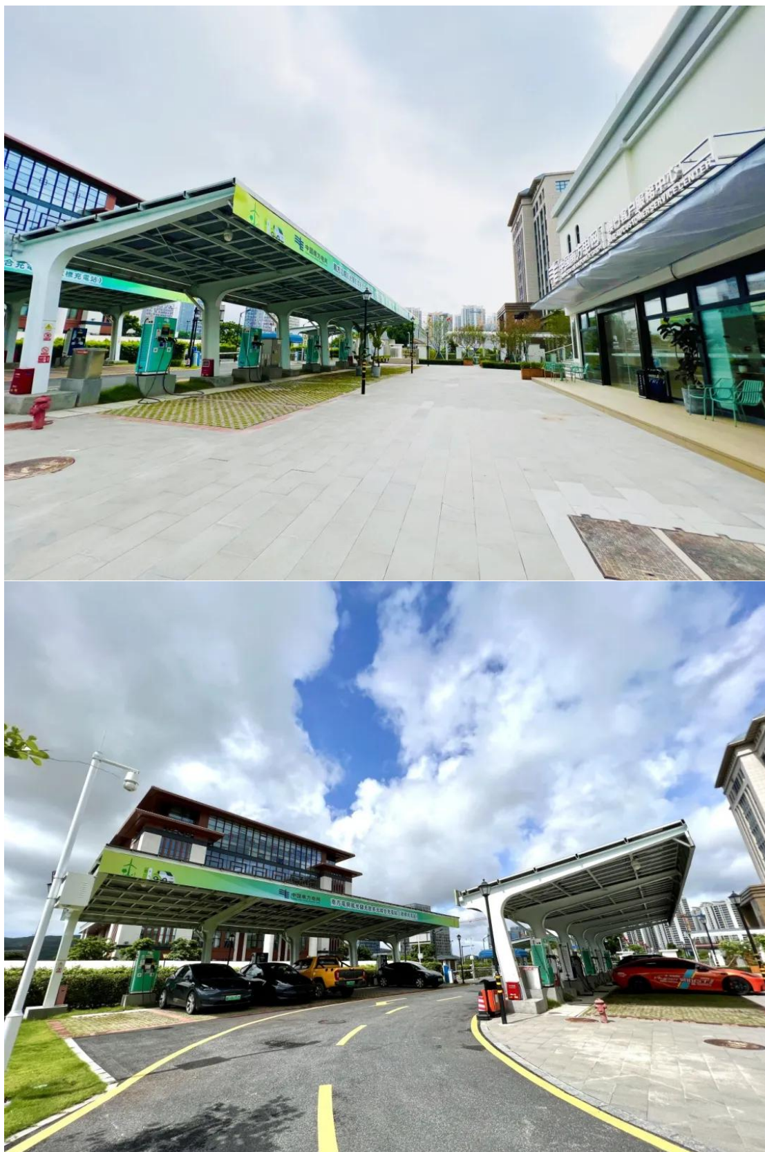
▲南方电网风光储充放多元综合充电站（欧标充电站）位于珠海横琴供电局内。目前，横琴已经实现欧标充电桩全覆盖，便利琴澳居民出行。（林丹丹 摄）
