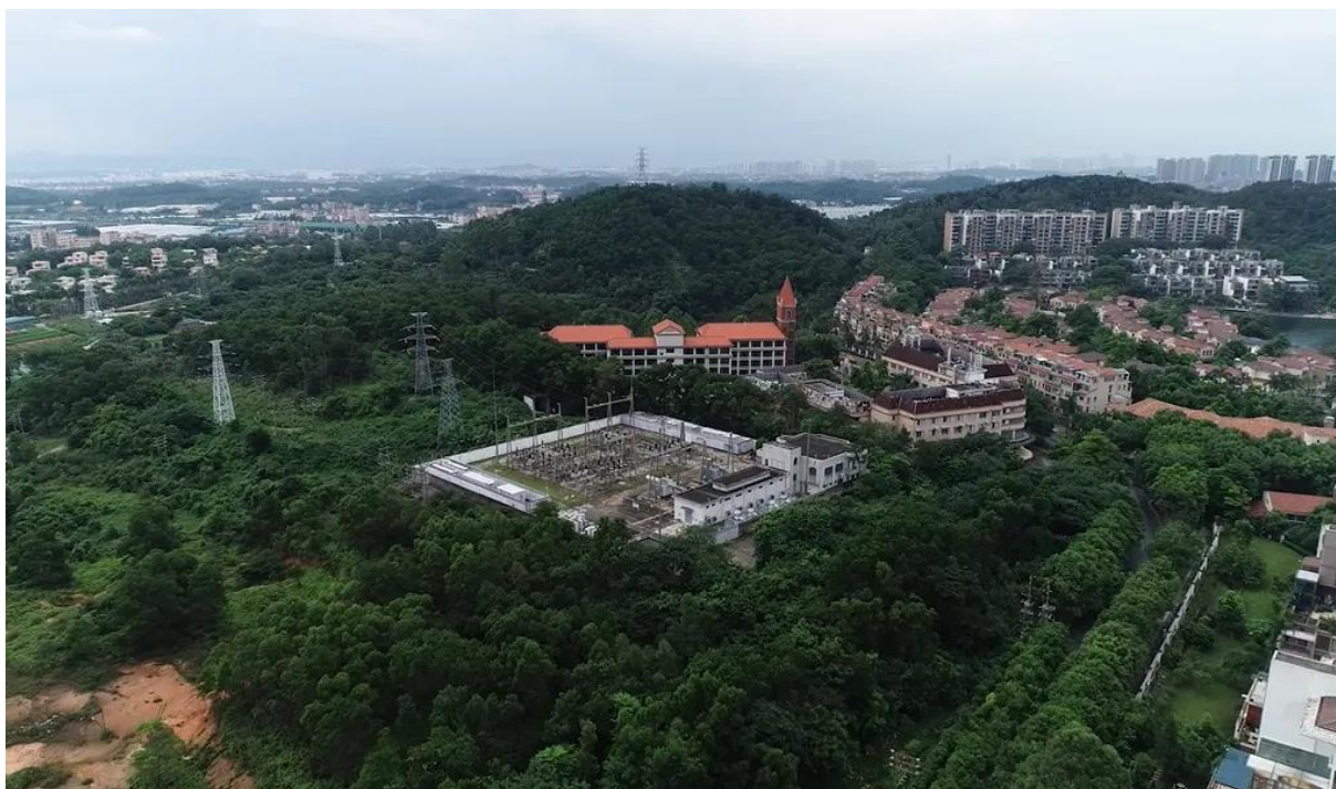
▲广州芙蓉新型储能电站航拍。（南方电网广东广州供电局 供图）
