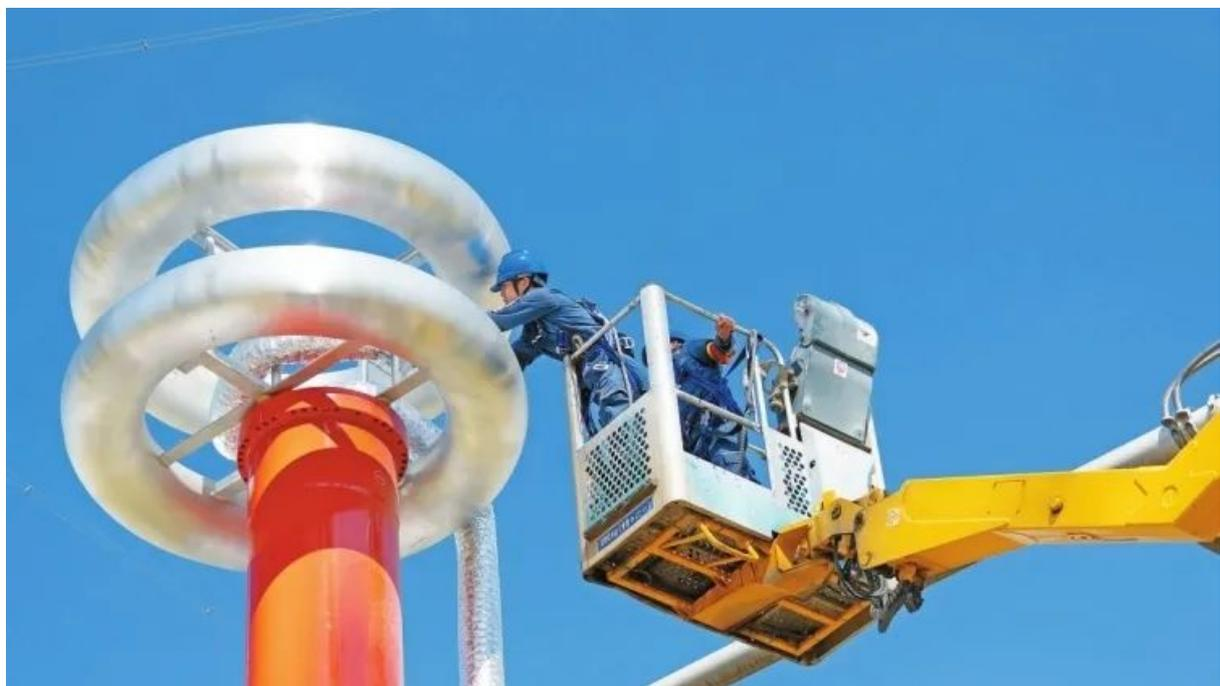
我国首台国产 $\pm 800$ 千伏直流高速开关在昆柳龙直流工程柳州换流站挂网运行。邓云天 摄
